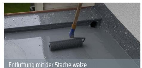
Entlüftung mit der Stachelwalze
