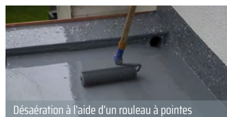
Application du revêtement
